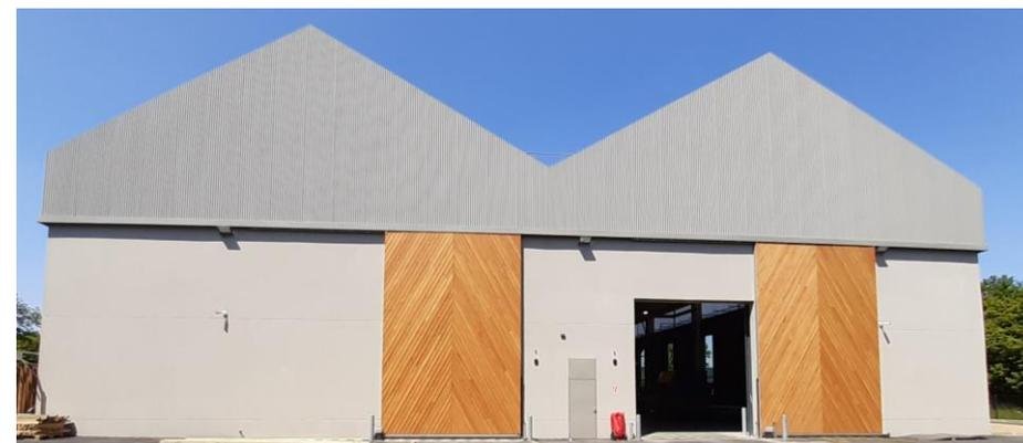
Le mur porteur en béton de bois a été choisi pour ses qualités acoustiques, pour sa résistance au feu, son déphasage thermique et pour sa quantité de matériau biosourcé.
